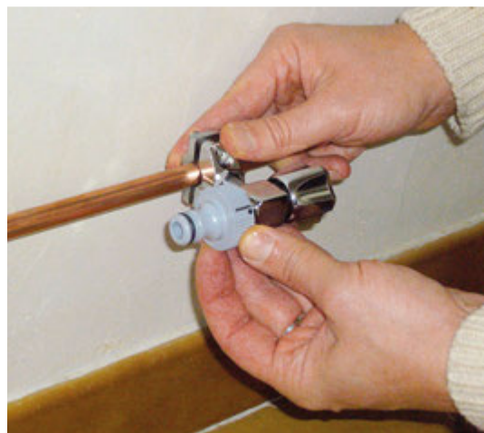
Met een prikkraan kun je een watertoevoer maken vlak bij het balkon zonder in de koperen leiding te hoeven zagen of te hoeven solderen.
